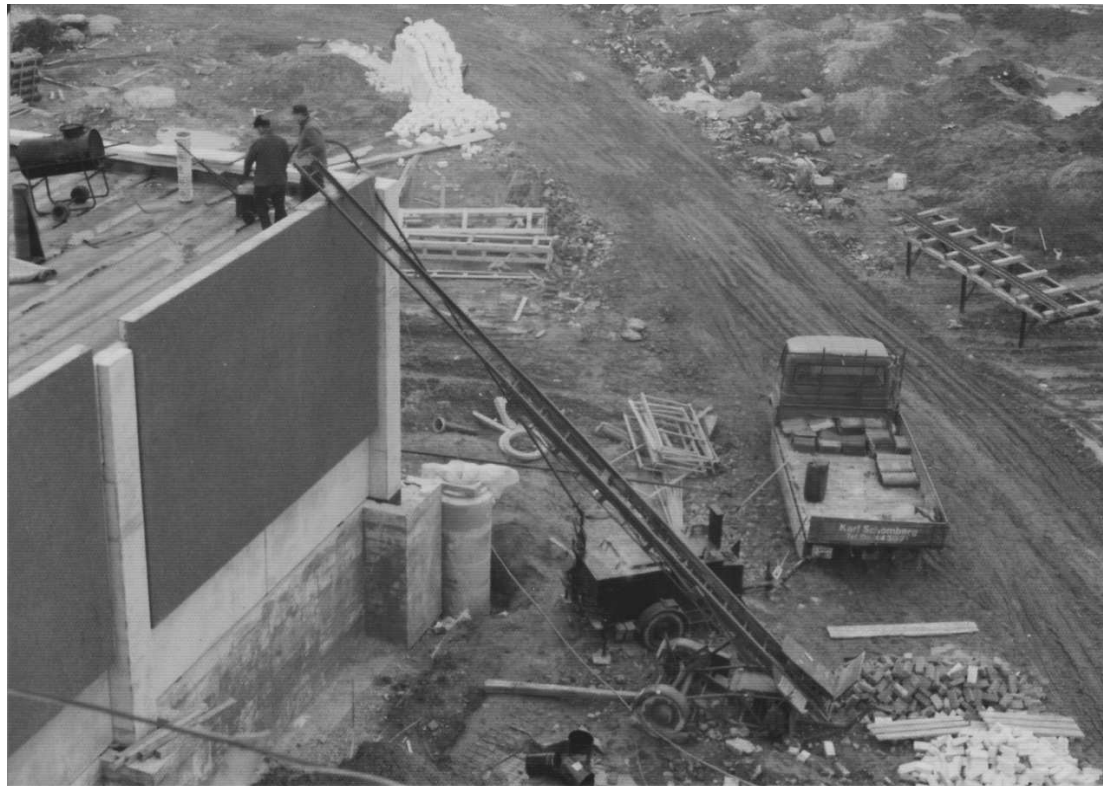
Hier ist ein Schrägaufzug aus dieser Zeit zu sehen.
